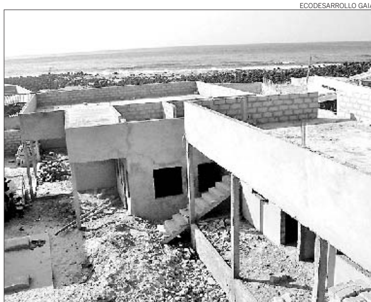
Aspecto de la escuela Coruña todavía en construcción
